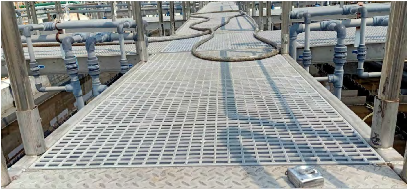
ในรูป ใช้ตะแกรงพลาสติกพีพีเกรดดิ่ง ยาว 1 เมตร มาตรฐานเหลือ 46 ซม. แบบปิดขอบพอดีได้ 2 แผ่น
