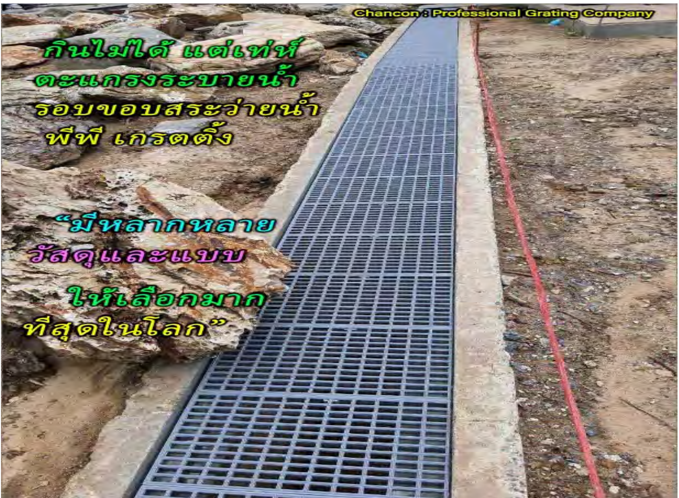
ในรูป ใช้ตะแกรงพลาสติกพีพีเกรดดิ่ง ยาว 1 เมตร มาตรฐานเหลือ 46 ซม. แบบปิดขอบพอดีได้ 2 แผ่น
